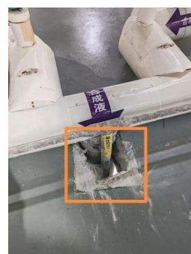
图 35 楼层管道孔洞
