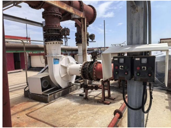
图 24 合成工段事故风机
